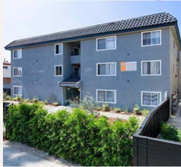
6 229 S NORMANDIE AVE, LOS ANGELES, CA 90004
