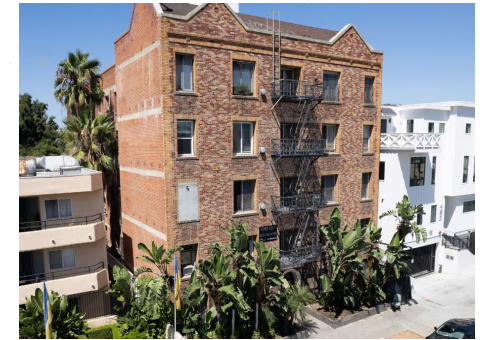
167 S Normandie Ave Los Angeles, CA 90004
