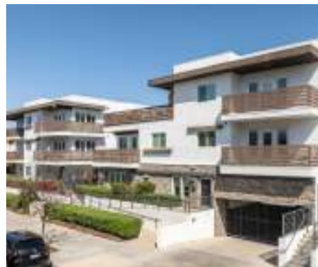
5825 CAMERFORD AVE Los Angeles, CA 90028
